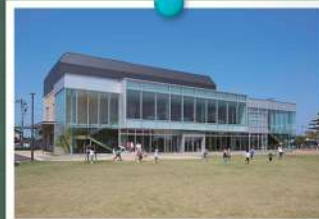
野々市市富奥防災コミュニティセンター
